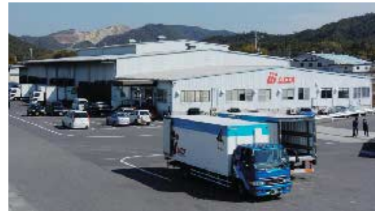
24時間稼働している呉営業所
