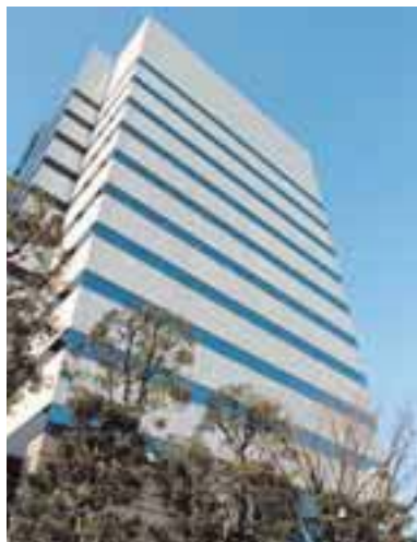
リクルートオフィスサポートが入る FOREFRONT TOWER II
