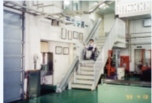
(改善後) 車椅子用階段昇降機の設定
