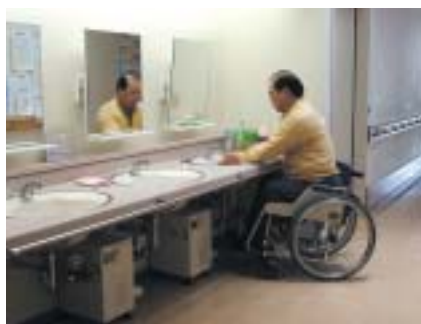
鏡の角度が前傾している洗面台(湖畔工場)。
