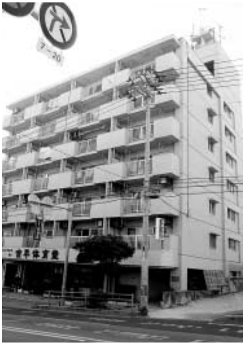
「ふれあいセンター」はこのビルの4階にある
