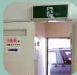
非常口も新たに設置
