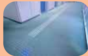
会社内には、助成金制度を利用して点字ブロックを敷設した。
