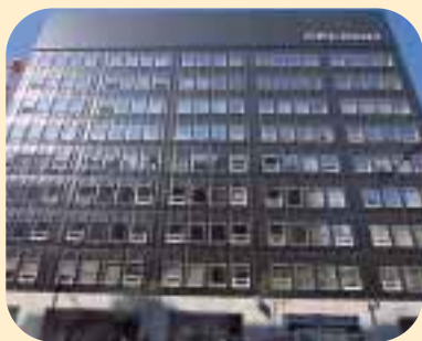
リクルートプラスの「リフレッシュルーム」は、リクルートの銀座7丁目ビル（G7ビル）の2階にある。
