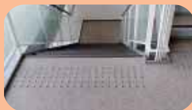
工場事務棟内の点字びょうブロック
