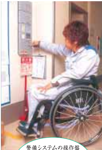
警備システムの操作盤を移設し、戸締りという大切な仕事を障害者にも任せられるようにした。
