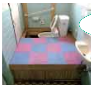
便座と同じ高さに床を上げた2階のトイレ
