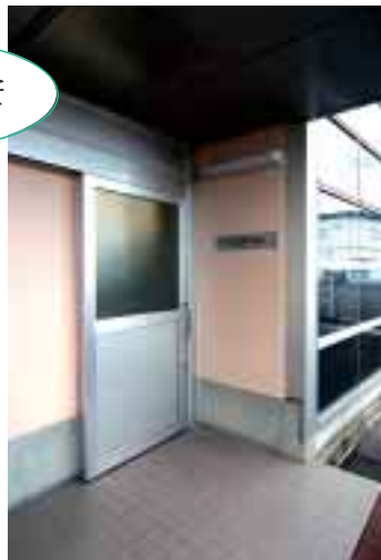
引き戸に改善した エントランスドア
