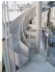
特例子会社は、洗面所や非常階段も障害者に配慮した作りになっている。
