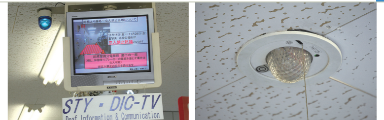
▲テレビを設置して視覚的に情報をアナウンス。 ▲フリッカーランプを全部署に設置。
