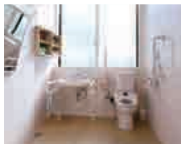
車椅子用にトイレを改修。
