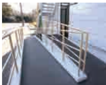
スロープを設置。
