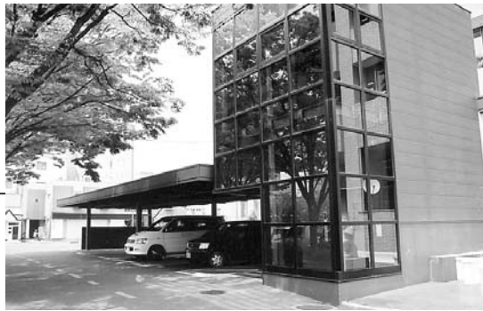
市役所のバリアフリー化も進む。 屋根付き駐車場からエレベーターがある
