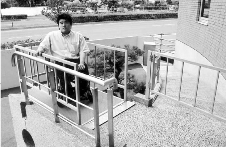
本社玄関前には昇降機とスロープが設置されている
