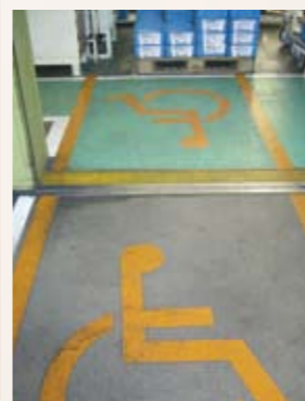
自動ドアを設置
