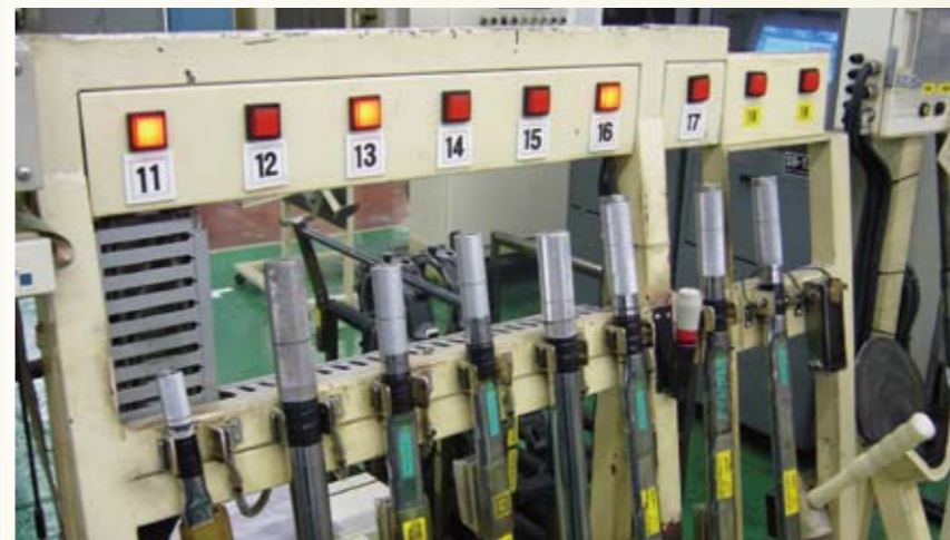
組立作業においてどの工具を使用すればよいか、ランプで知らせる
