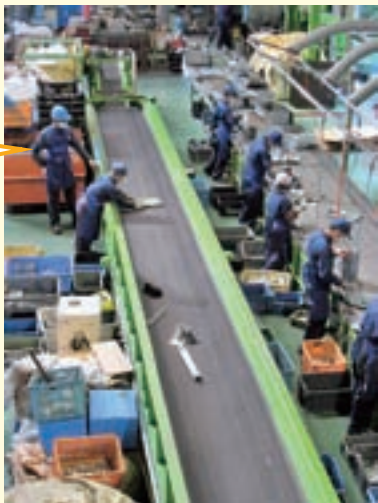
佐合さんを配置している解体工程ライン
