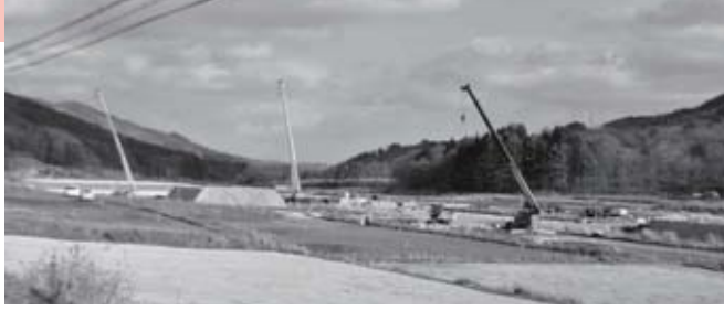
除染作業中の飯館村
