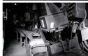
地震直後の福島製鋼の工場
